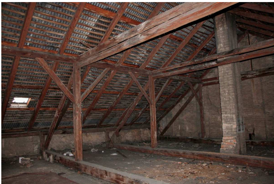
2. Vaznicová soustava sedlového krovu
