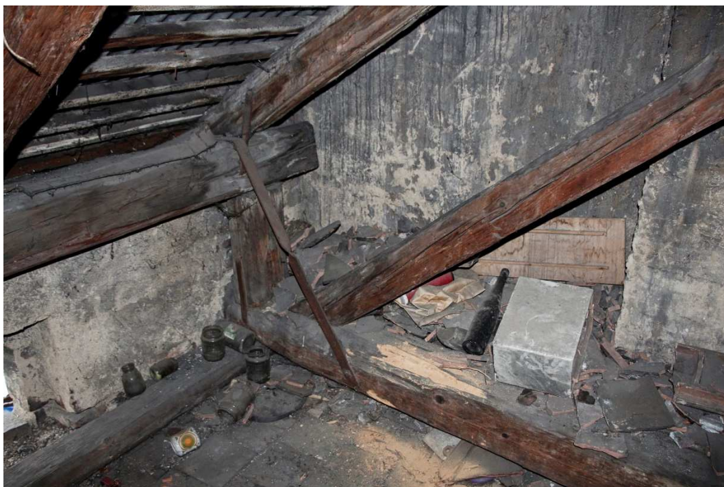
5. Vazba u štítu na východním nároží, lehce poškozená tesaříkem
