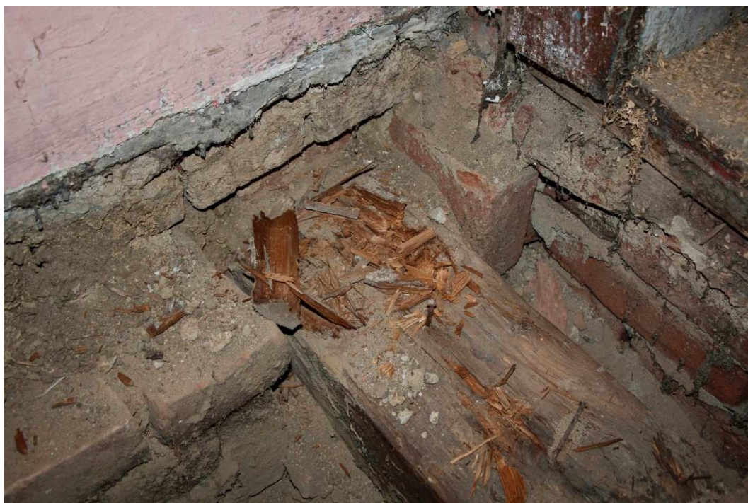
10. Příklad středně těžce poškozeného zhlaví stropního trámu celulózovorní houbou
