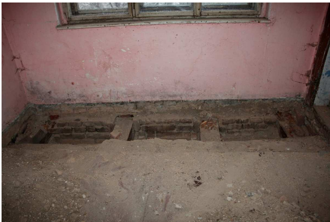
9. Jedna z pásových sond do stropu nad 1. NP
