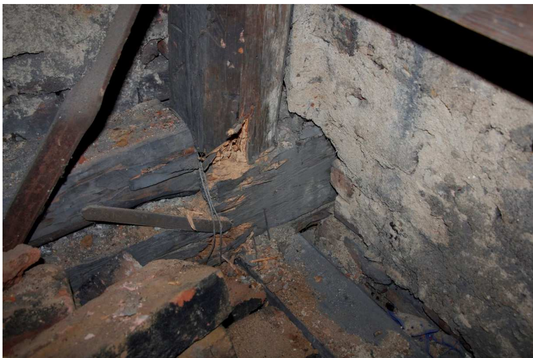
4. Spodní část vazby na východní straně vedle schodiště, značně poškozená celulózovými houbami a tesaříkem
