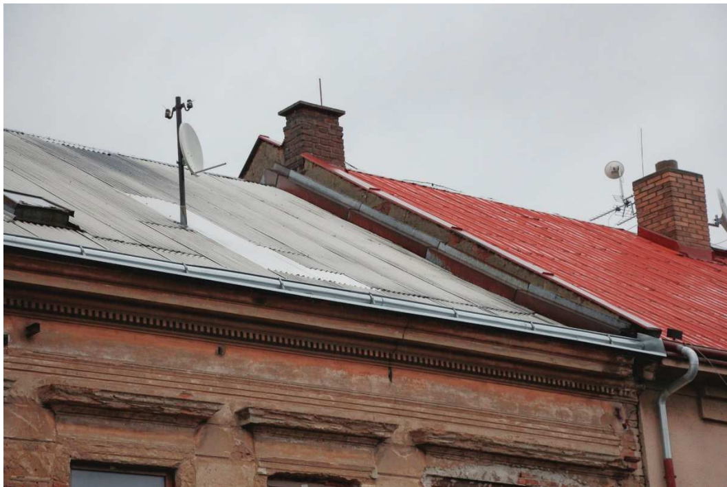
1. Stav střešní krytiny z vlnitého hliníkového plechu
