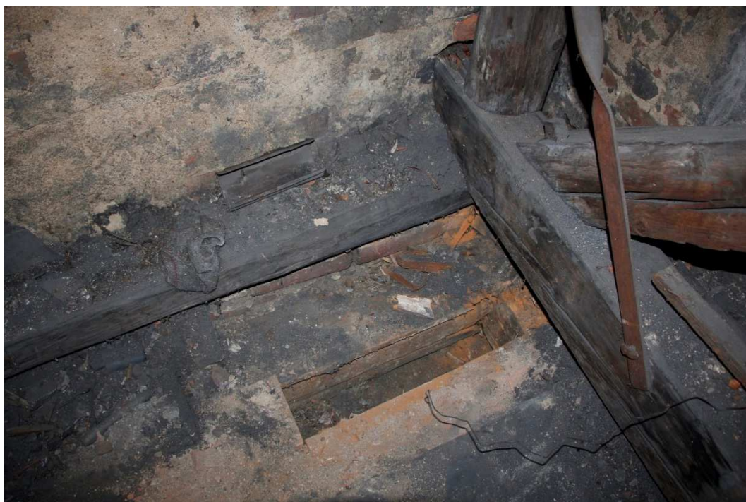
6. Vazba u štítu na západním nároží a navazující strop, těžce poškozený dřevomorkou a červotočem.
