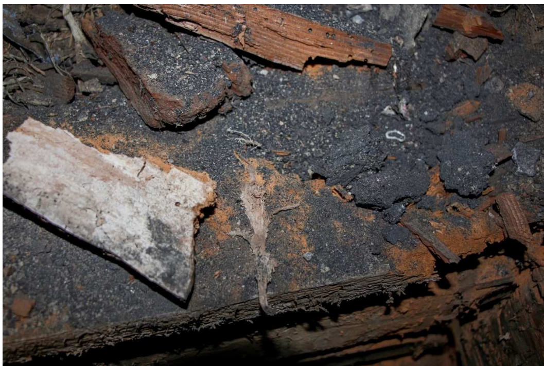
7. Detail mycelia dřevomorky z ohniska na snímku č. 6
