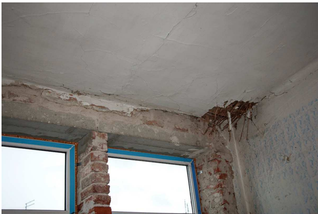
8. Havarijní stav stropu těžce poškozeného dřevomorkou v ohnisku na západním nároží
